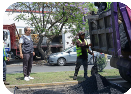
Refuerza Pepe Chedraui acciones de bacheo para mejorar seguridad vial en la capital
